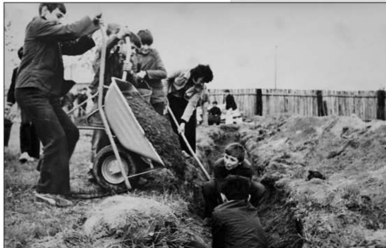
Postavljenje drenažnih cijevi na igralište.
